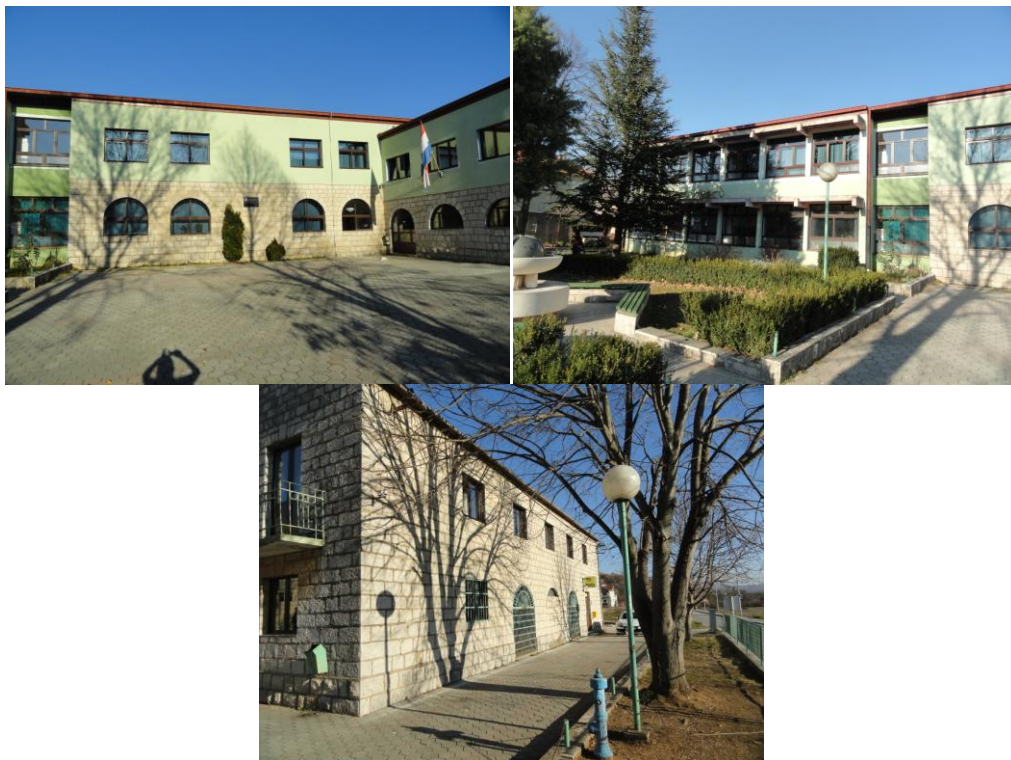
Slika 1. Južno pročelje –Događeni novi dio i stari dio škole
