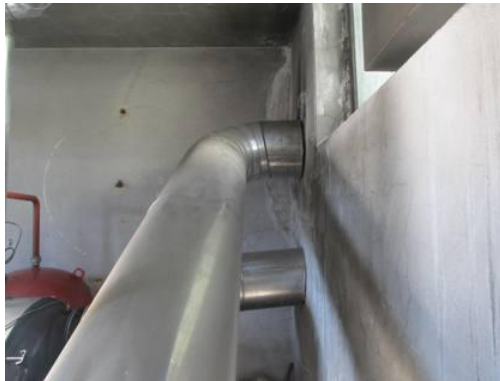
Slika 8. Priključak kotlova na dimovodni kanal
