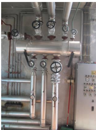
Slika 10. Upravljačka ploča u kotlovnici
