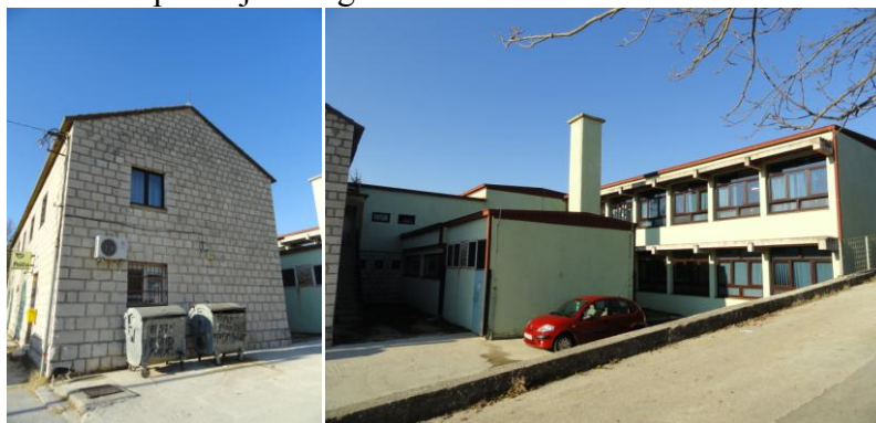
Slika 2. Istočno pročelje-stari dio i dograđeni novi dio s kotlovnicom
