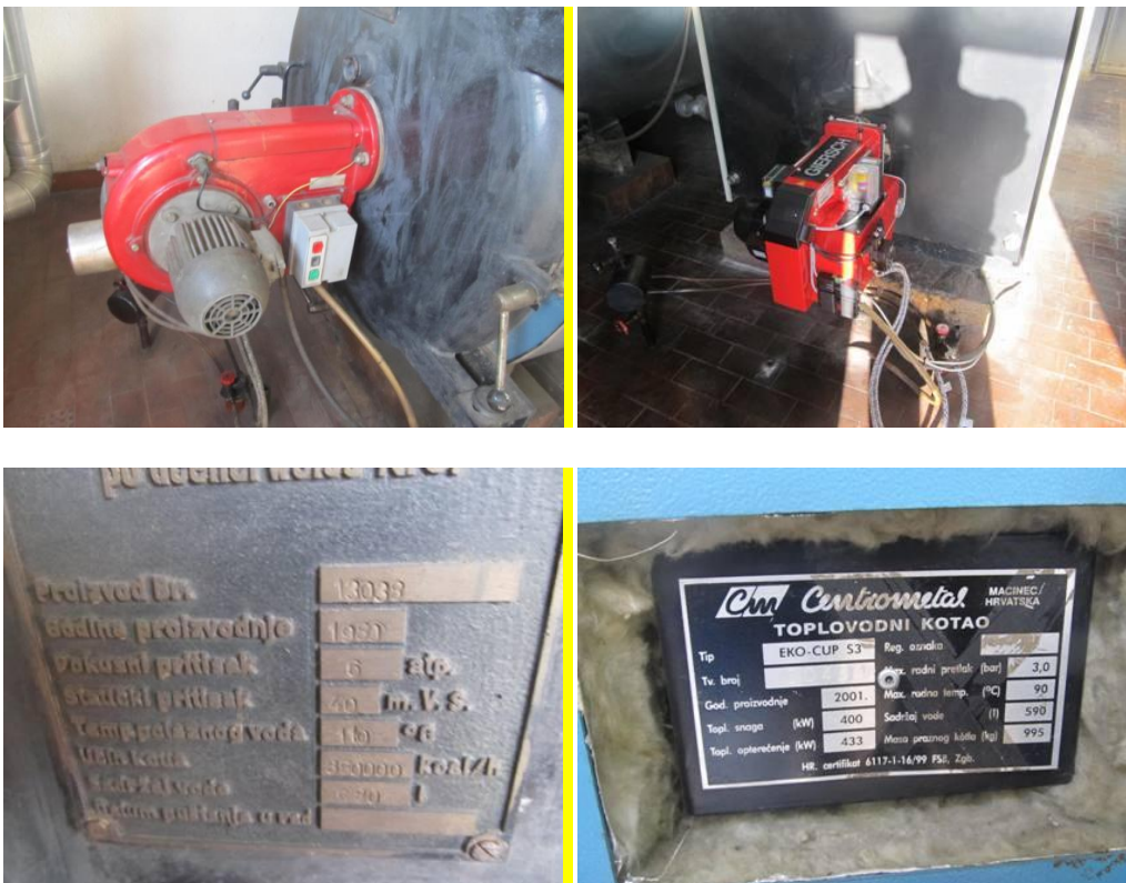
Slika 6. Toplovodni kotlovi sa plamenicima
