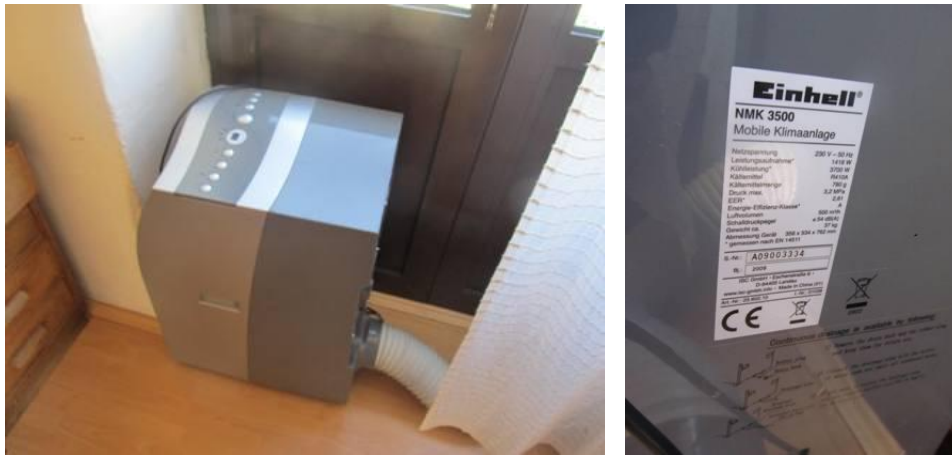
Slika 15. Vanjske i unut. jedinice pojedinačnih klima uređaja
