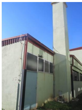
Slika 9. Izlaz dimnjaka na krov
